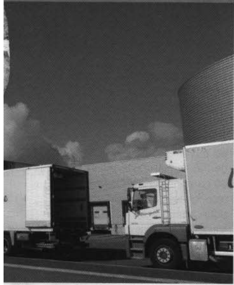
L'usine Monts Fournil à Saint-Jean-de-Monts (85). Les livraisons des 180 magasins sont effectuées par l'intermédiaire de huit plates-formes. Activité de production d'environ 200 palettes/jour.
